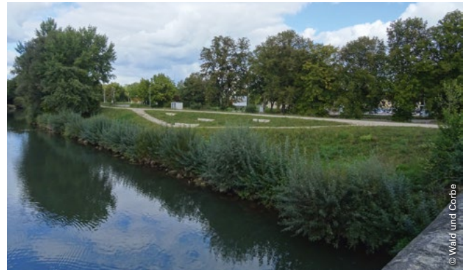
Hochwasserschutzmauer links des Neckars in Wendlingen/Neckar
