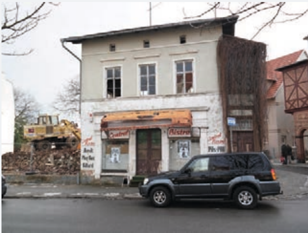
Gefährdung der geschlossenen Stadtstruktur in Ballenstedt
