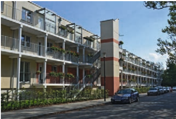
Rückbau Plattenbau bis auf das Kellergeschoss und Neubau Laubenganghaus
