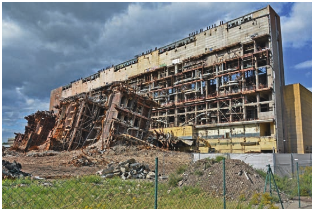
Reste vom Kraftwerk Thierbach nach dessen Teilsprengung (Sommer 2015)
