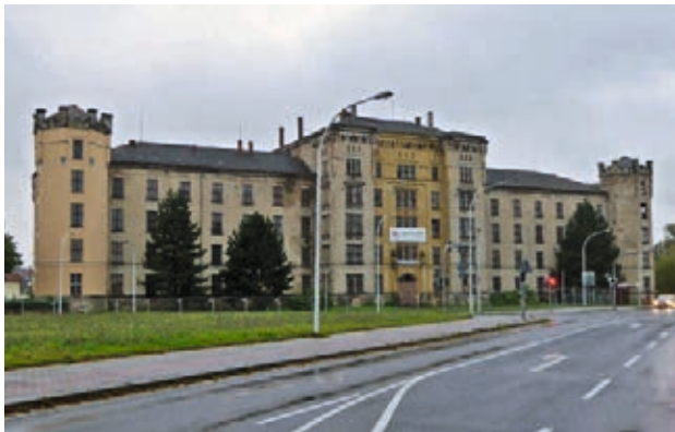
Zittau – Bürgerprojekt zur Wiederbelebung der ehemaligen Mandaukaserne · Foto: Fachgebiet Stadtbau + Ortserneuerung
