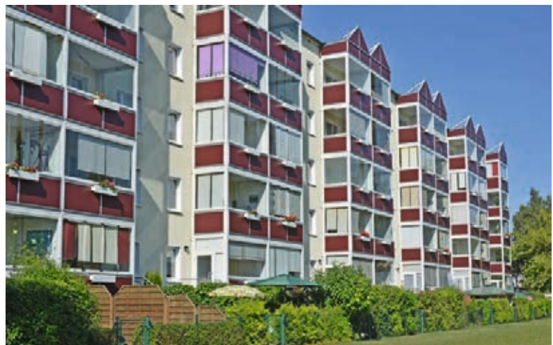
In den 1990er-Jahren sanierte Wohnbauten
