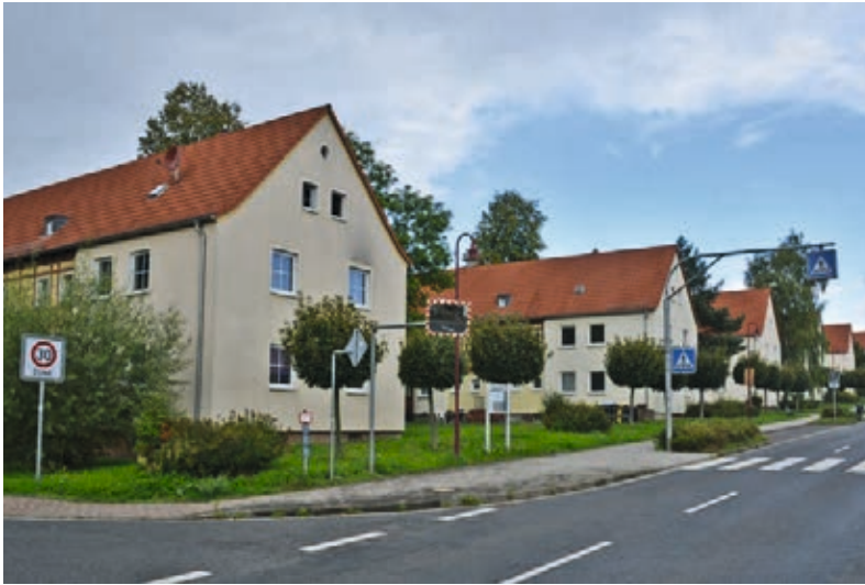
Weitgehend sanierte Werkssiedlungsbestände der 1930er-Jahre
