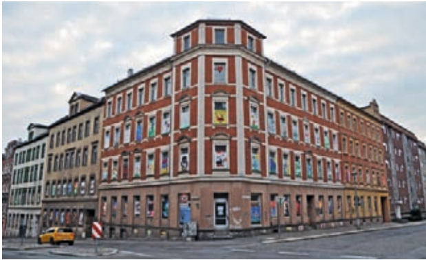
Leerstandsobjekt an einer stark befahrenen Hauptstraße
