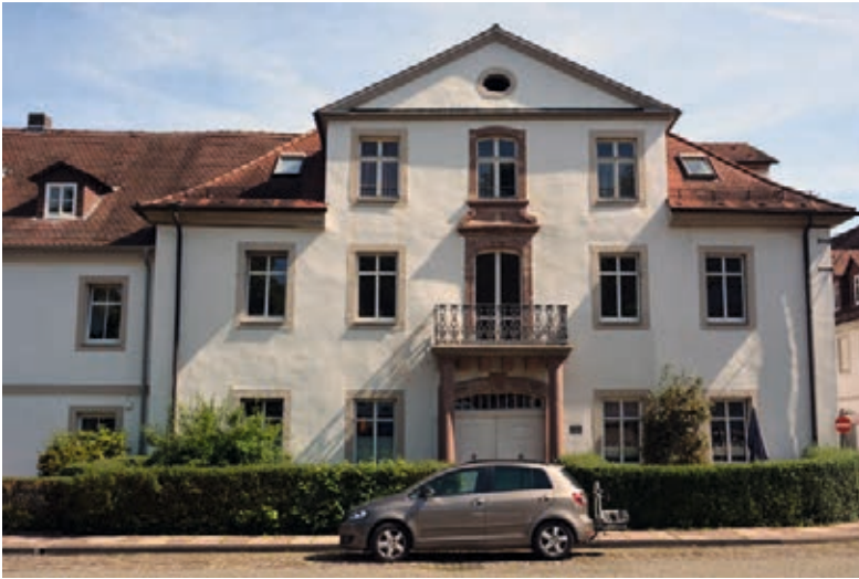
Leerstehende Wohnungen im Obergeschoss eines Wohngebäudes
