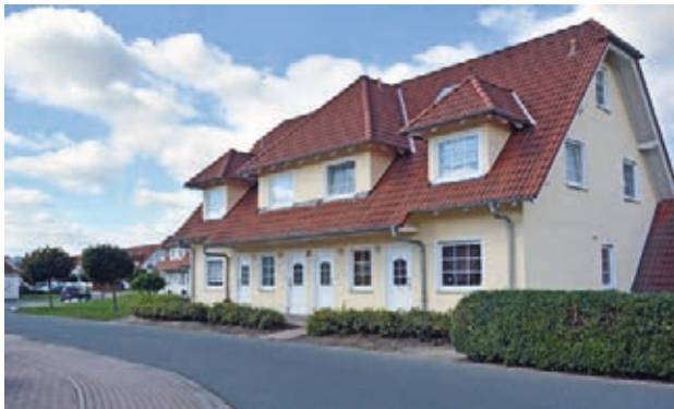
Leerstehende, nach 1990 errichtete Gebäude im Ortsteil Köhra
