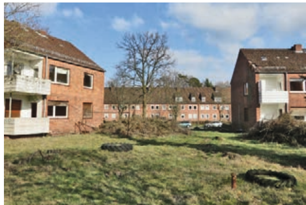
Komplett leerstehende und verwahrloste Wohngebäude Dresdner Straße/Berliner Straße
