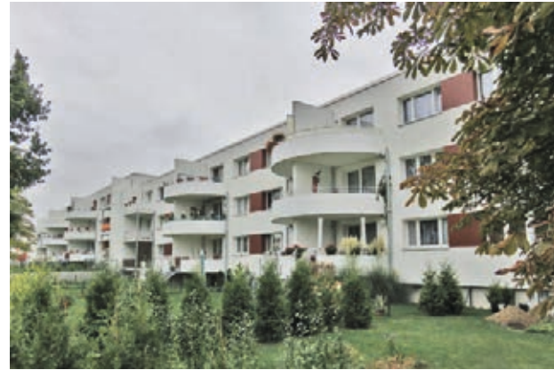
Rückbau von sechs auf drei Vollgeschosse
