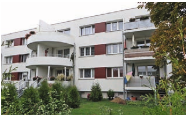
Das Wohngebiet Königshufen in Görlitz ist infrastrukturell gut ausgestattet und bei vielen Görlitzern beliebt. Die örtliche Wohnungsbaugesellschaft hat sich deshalb zum Rückbau von drei Geschossen entschieden, die verbleibenden Gebäude werden Schritt für Schritt zu einer vorstädtischen Wohnsiedlung mit einem hohen Grünanteil umgebaut.
