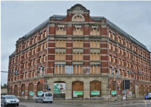
Leerstehendes, aber erhaltenswertes Altbauobjekt mit zwischenzeitlichen Sicherungsmaßnahmen
