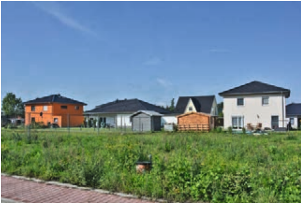
Auf dem Baugrundstück von abgebrochenen Plattenbauten werden heute Einfamilienhäuser errichtet
