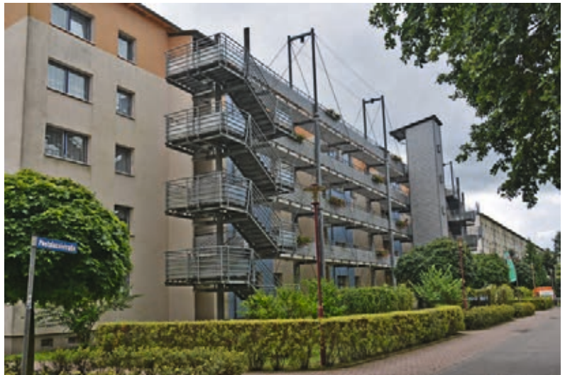
Sanierter Geschosswohnungsbau mit materialaufwendiger Laubengangkonstruktion
