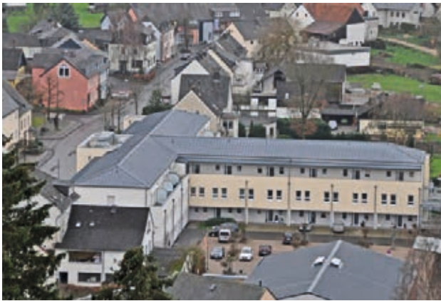
Altenwohnheim am neuen Dorfplatz im Ortskern Schöneckens Foto: Fachgebiet Stadtumbau + Ortserneuerung
