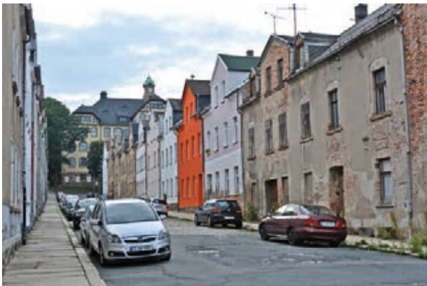
Leerstehende Gebäude in unmittelbarer Nachbarschaft zu sanierten Objekten
