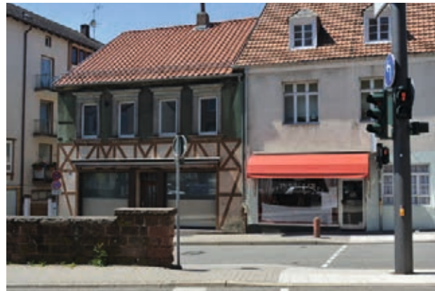
Leerstehendes Wohngebäude in der Innenstadt
