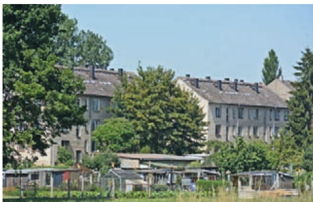
Leerstehende Mietwohnungsbestände der ehemaligen Gutsarbeiter in schlechtem Sanierungszustand
