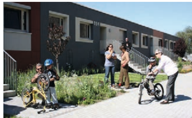
Beim Projekt „Plattenbaukasten“ im randstädtischen Dessauer Wohngebiet Kreuzbergstraße sind nach dem Rückbau von vier Geschossen das verbleibende Erdgeschoss plus Keller an acht Familien veräußert worden. Die Gebäudehülle wurde gemeinsam umgebaut, der Innenausbau erfolgte durch jede Familie individuell. Foto: Fachgebiet Stadtumbau + Ortserneuerung
