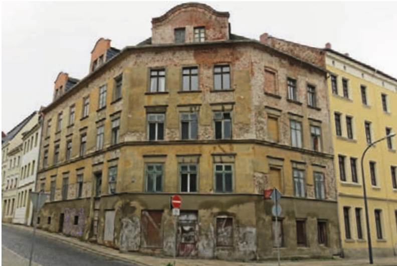
Direkte Nachbarschaft sanierter und komplett leerstehender Gebäude
