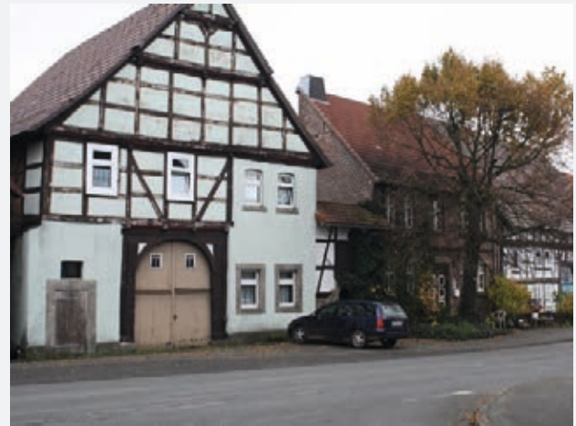
Sanierungs- und Modernisierungsbedarf – stadtbildprägende Gebäude in Diemelstadt-Rhoden
