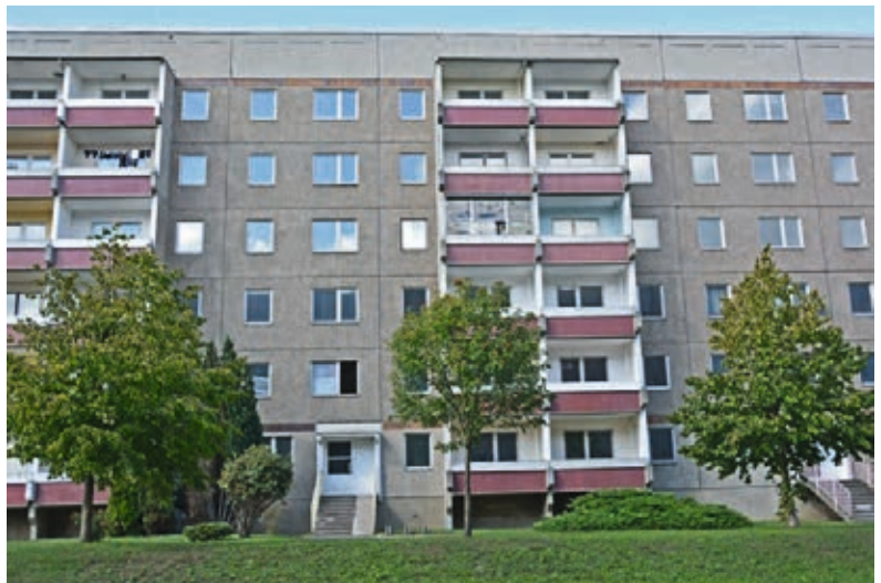
Unsanierter und weitgehend leerstehende Geschosswohnungsbestände
