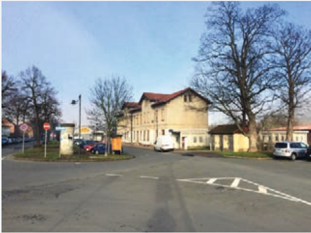
Bahnhof Kahla in suburbaner Lage und doch direkt neben Einkaufszentrum und Altstadt mit 10-Minuten-Fussweg (eigene Aufnahme Studierendenprojekt)
