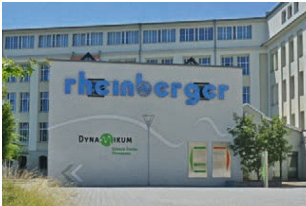
Revitalisierung der ehemaligen Schuhfabrik „Rheinberger“ zum heutigen Dynamikum
