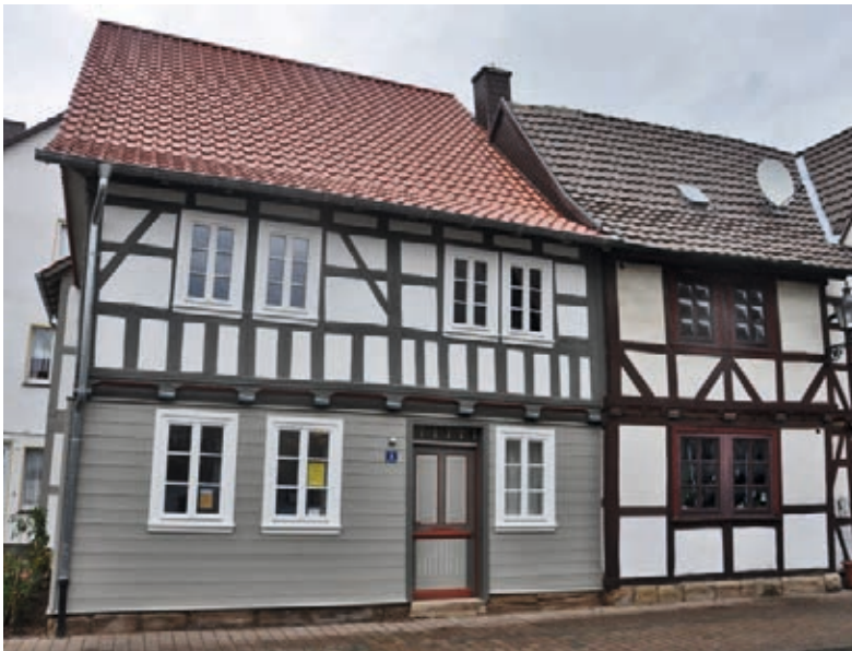
Fachwerkmusterhaus der Bürgergruppe in Wanfried. Foto: Fachgebiet Stadtumbau + Ortserneuerung
