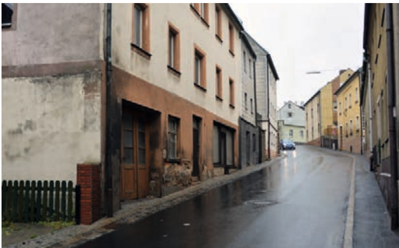
Hohe Anzahl leerstehender Wohngebäude in teils schlechtem Sanierungszustand in der Egerstraße
