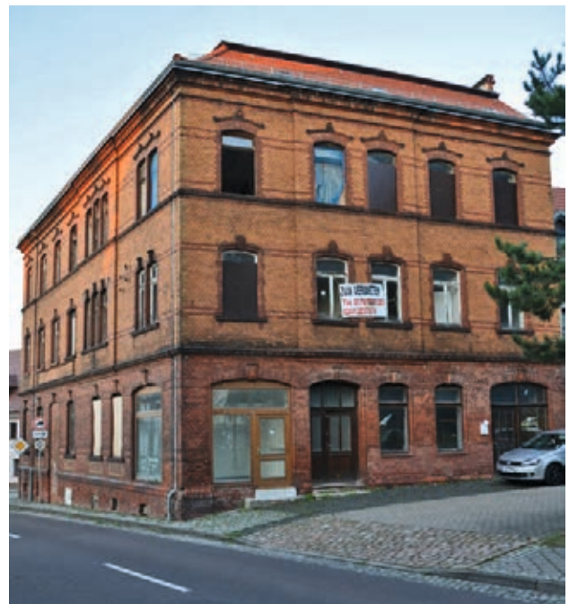
Leerstand mit Sicherungsmaßnahmen Kirchplatz 1
