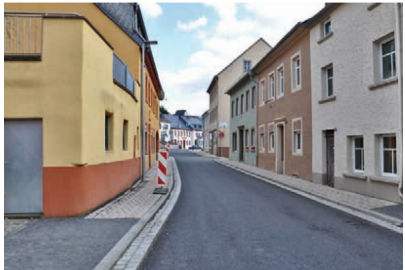
Erneuerung der Ortsdurchfahrt und instandgesetzte Gebäude Foto: Fachgebiet Stadtumbau + Ortserneuerung
