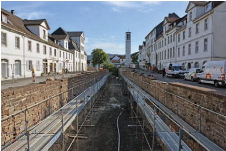
Sanierungsmaßnahmen an den Mauern der Hafenanlage
