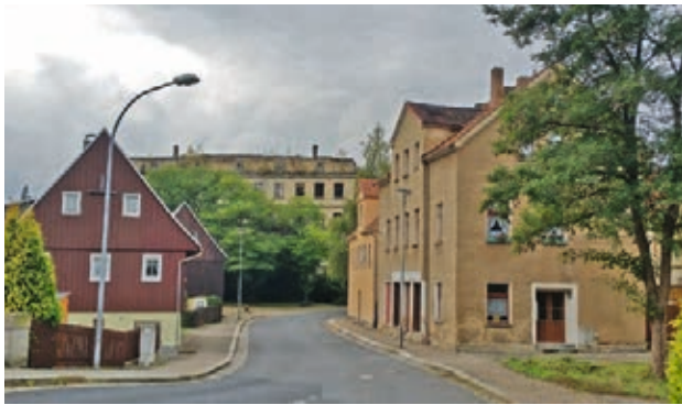
Seiffhennersdorf - Leerstandsobjekte Wohnen und Gewerbe im Ortskern · Foto: Fachgebiet Stadtbau + Ortserneuerung
