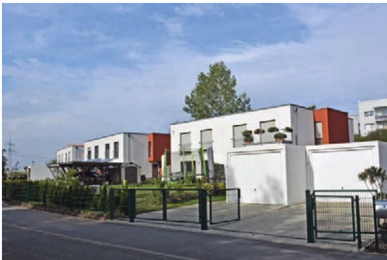
Errichtung von Doppelhaushälften auf einer Rückbaufläche
