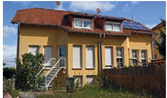
Leerstehendes Einfamilienhaus im Ortsteil Belgershain
