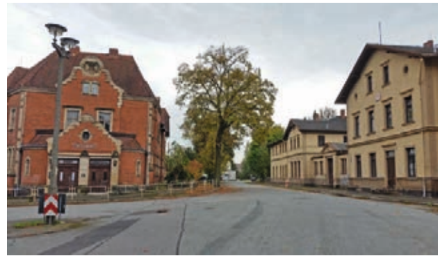
Seiffhennersdorf – leerstehende Schlüsselimmobilien Bahnhof und Postamt · Foto: Fachgebiet Stadtbau + Ortserneuerung
