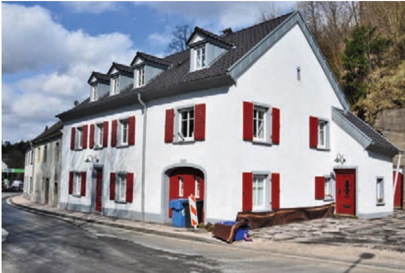
Aufwändig saniertes Altbaubjekt Foto: Fachgebiet Stadtumbau + Ortserneuerung
