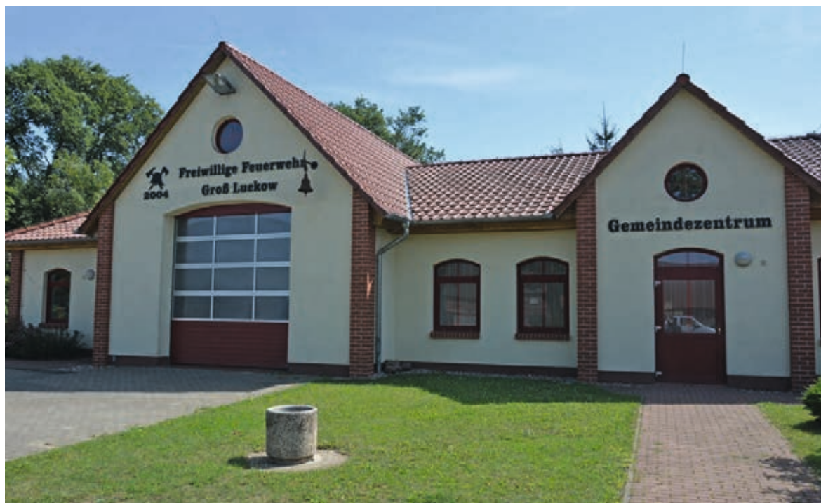
Neu errichtetes Gemeindezentrum und Sitz der freiwilligen Feuerwehr in Groß Luckow
