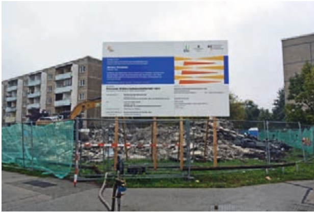
Rückbau leerstehender Wohneinheiten im Süden der Innenstadt
