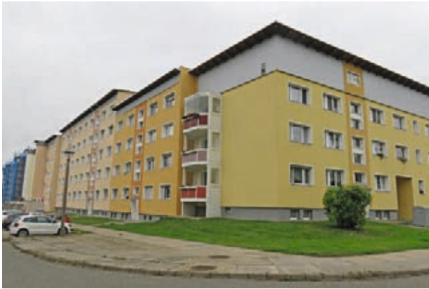
Rückbau von sechs auf vier Vollgeschosse
