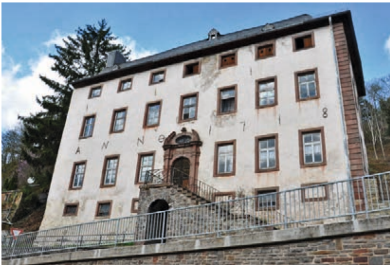
Leerstehende historische Objekte in schlechtem baulichen Zustand: Altes Kloster und Objekt „Unter der Pfordt Nr. 2“ Fotos: Fachgebiet Stadtumbau + Ortserneuerung
