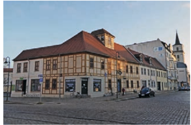
Denkmalgeschütztes Ensemble Schwabebau und Alte Bäckerei – bürgerschaftlich getragene Immobilienaktivierung
