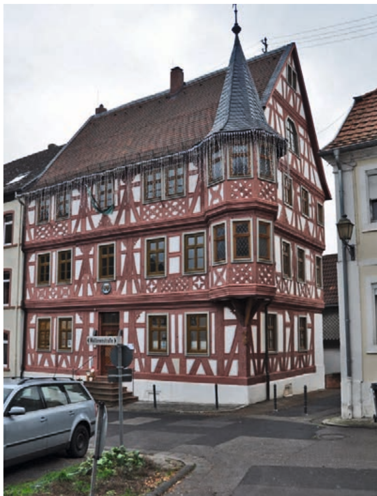
Saniertes Historisches Rathaus in Lambrecht (Pfalz) · Foto: Fachgebiet Stadtumbau + Ortserneuerung
