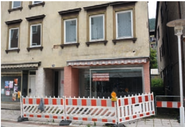
Leerstehendes Gebäude in der Fußgängerzone
