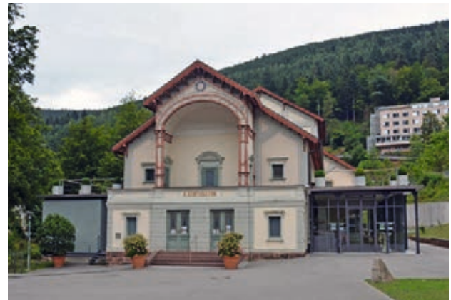
Sanierung des königlichen Kurtheaters durch den Förderverein
